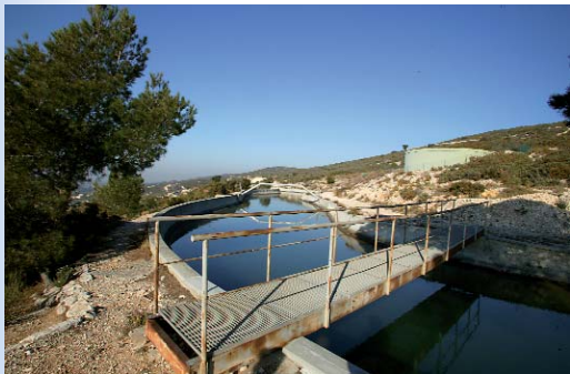
Le canal de Marseille, paisible en apparence
